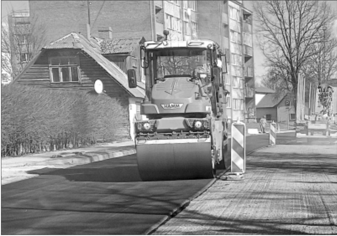
Top jauns asfalta segums. Kā jau iepriekš rakstījām laikrakstā “Vaduguns”, galvenos būvdarbus uz Brīvības ielas (asfalta seguma atjaunošanu un komunikāciju nomaiņu) paredzēts pabeigt līdz maija beigām.
