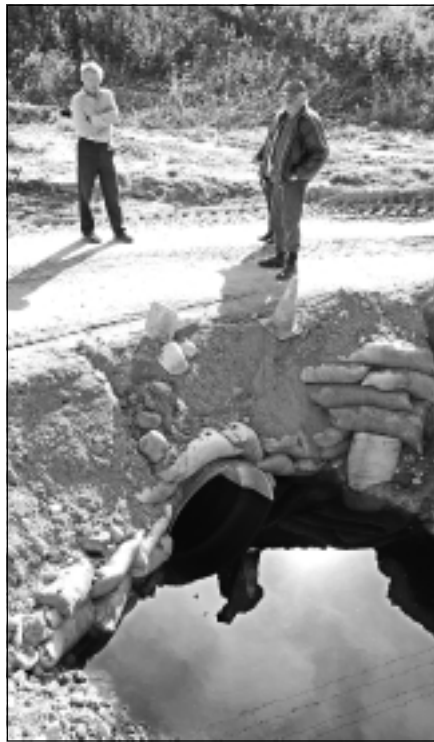
Ceļš kā kalnos. Ceļu Keiši - Kaši - Pliešova lietavu laikā izskaloja vietā, kur tek Supenka. Ceļu izskaloja virs caurtekas. Lai tiktu pāri, zemnieki pašu spēkiem uzbēra granti. Ceļš šajā vietā ir likumains, turklāt strauji ved uz leju, tad augšā. Lai tiktu pāri izskalojuma vietai, traktors ar piekabi brauc ļoti prātīgi - kā kalnu ceļā.
