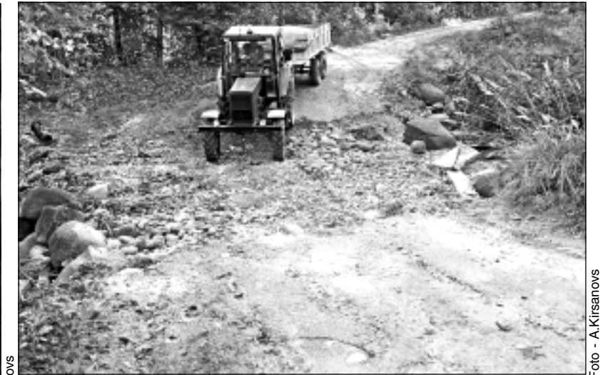
Ceļš kā kalnos. Ceļu Keiši - Kaši - Pliešova lietavu laikā izskaloja vietā, kur tek Supenka. Ceļu izskaloja virs caurtekas. Lai tiktu pāri, zemnieki pašu spēkiem uzbēra granti. Ceļš šajā vietā ir likumains, turklāt strauji ved uz leju, tad augšā. Lai tiktu pāri izskalojuma vietai, traktors ar piekabi brauc ļoti prātīgi - kā kalnu ceļā.
