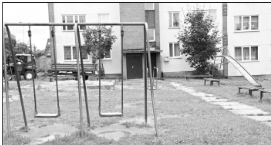
Raiņa ielas 39 pagalms. Rotaļu konstrukcijas - vēl no padomju laikiem.
