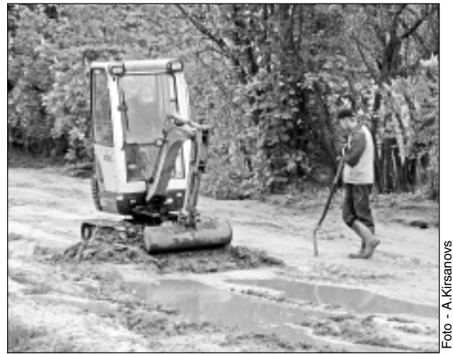
Meklē akas. Tas, ka ielā parādījās tā saucamais "robots", kas attīrīja no zemes uzbēruma kanalizācijas aku lūkas, iedzīvotājos arī raisīja aizdomas, jo kāds no strādniekiem it kā bija apjautājies, kur tās akas atrodas.
