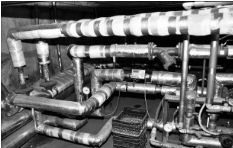
Jaunais siltummezgls. Tā izskatās jaunais, nosiltinātais siltummezgls. Siltumtrases un karstā ūdens vada cauruļu izolācija, ieskaitot darba samaksu, kopumā izmaksāja 414 latus.
