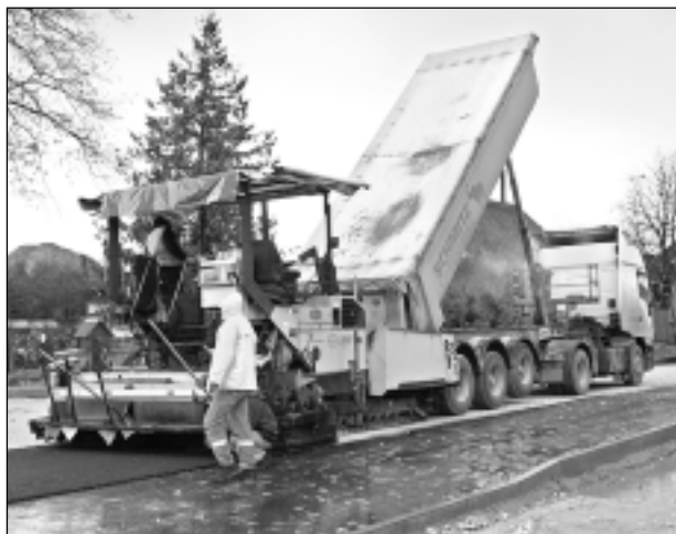
Klāj asfaltu. Asfaltbetonu šurp ved no Gulbenes, bet asfalta ieklājēju uzmanīgi vada Zigmunds Budrēvičs.
