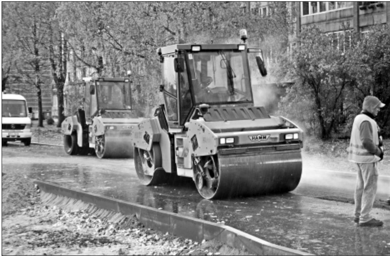
Kūp vien! Asfalta veltņiem noblietējot melno masu, gaisā paceļas karsti tvaiki. Šo tehniku vada Juris Rakštelis un Aigars Krūmiņš.
