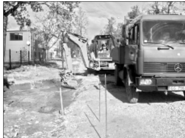
Ekskavators izņem gruntskārtu nobrauktuvei ceļā uz kurināmā noliktavu. Tad bērs smilti, šķembas, un "Balvu Enerģijai" būs piebraucamais ceļš pie noliktavām.
