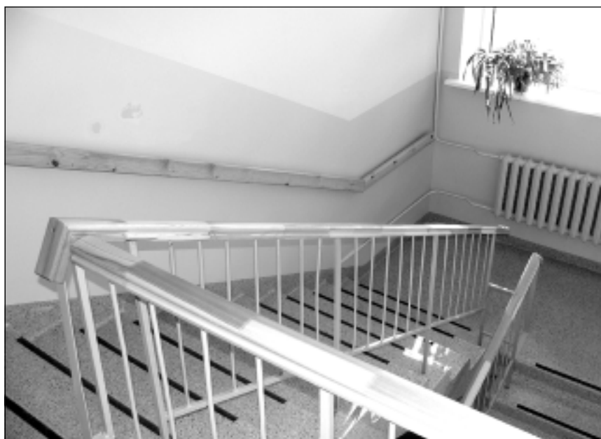
Izremontētā kāpņu telpa. Veikts kosmētiskais iekštelpu remonts, restaurētas kāpņu margas.
