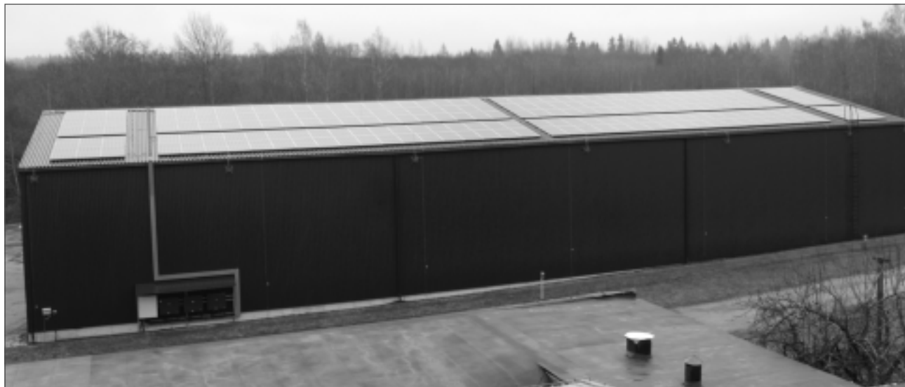
Izvieta uz jumta. Saules paneļus izvietoja uz šķeldas noliktavas jumta. Tieši šeit atrodas saules enerģijas elektrostacija, kas šobrīd ir lielākā Latgalē.
