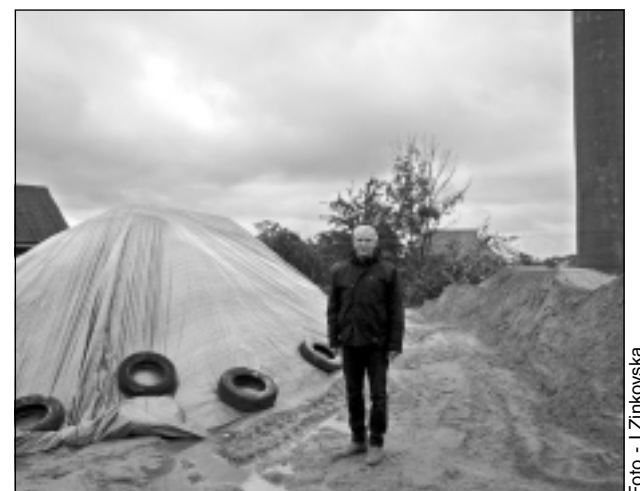
Sagatavots smilts-sāls maisījums. Pašvaldības aģentūrā “SAN-TEX” jau sagatavots smilts-sāls maisījums, kas nepieciešams pilsētas ielu, ietvju un laukumu kaisīšanai. Lai lietotu to neaizskalotu, pirms rodas pēc tā nepieciešamība, kaudze nosepta ar plēvi. Uzņēmuma Labiekārtošanas un apzaļumošanas nodaļas vadītājs Juris Kairišs pastāstīja, ka jau tuvākajā laikā uzņēmumā pabeigs kaisāmā materiāla sagatavošanu. Uzņēmumam aktuāli arī citi jautājumi. Pagājušās nedēļas nogalē J. Kairišs devās uz semināru par ieteicamāko niedru novākšanas metodi, kas nozīmīga arī mūsu pilsētai, jo dzīvojam divu ezeru krastos.
