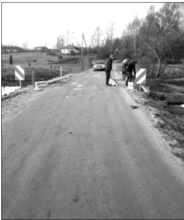
Tilts atjaunots. Šķilbēnu pagastā atjaunots tilts pāri Rikas upei, ko šogad augustā izskaloja gadsimta lietavu izraisītie plūdi. Notiek pēdējie darbi uz tilta - apmaļu nostiprināšana.
