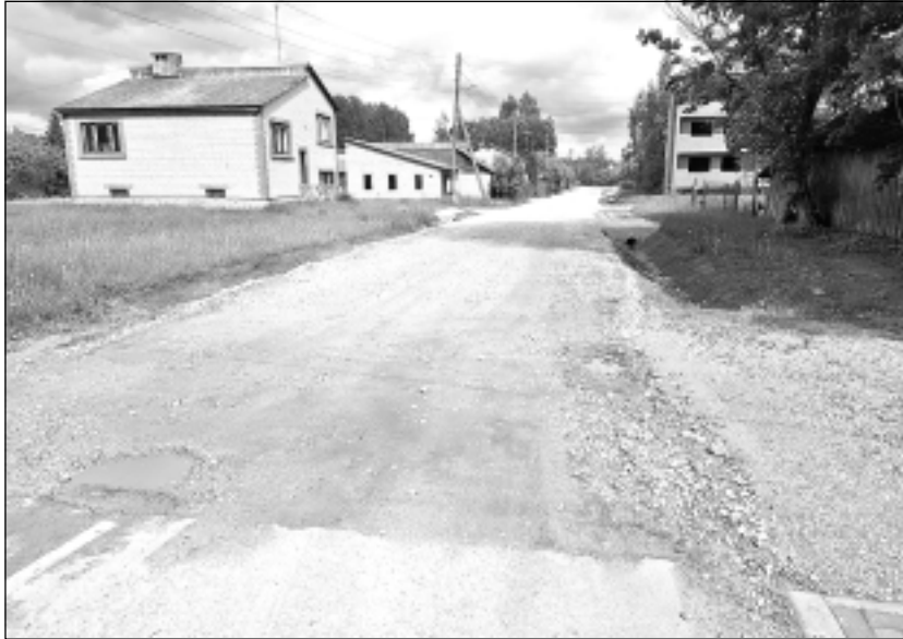
Ceļinieku iela. Vēl neilgu laiciņu ielas iedzīvotājiem jāsadzīvo ar neērtībām.
