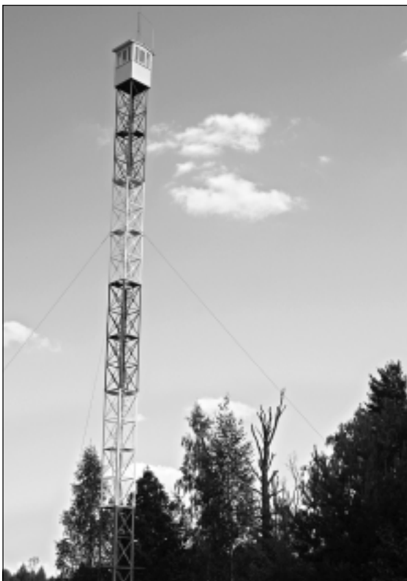
Atjaunotais tornis. Rekonstruēts ugunsnovērošanas tornis Meirānos, kas atrodas Balvu mežniecības teritorijā. Tam ir nomainītas atsaites, nokrāsota sarga būda un izdarīti citi darbi, lai tornis būtu drošs un arī vizuāli glīts.
