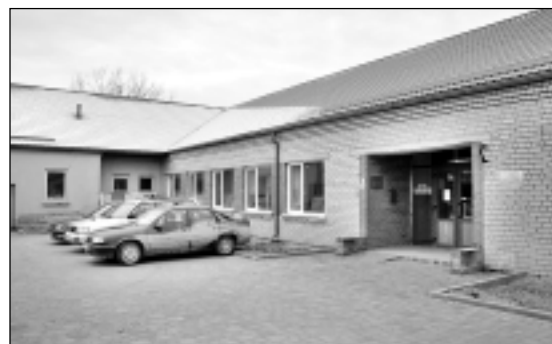
Balvu biroja ēka. Austrumlatgales virsmežniecības Balvu birojs atrodas Balvos, Bērzpils ielā 62 - vienā ēkā ar Pārtikas un veterinārā dienesta kantora telpām. Abas iestādes atrodas Zemkopības ministrijas pārziņā, tādēļ jauna ēka biroja vajadzībām nebija jāiegādājas.
