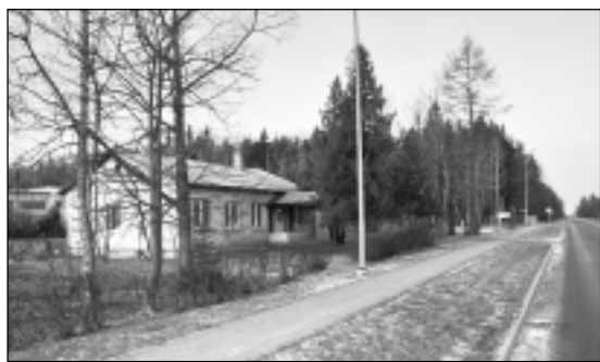
Bijusi mežniecības ēka. Bijusi mežniecības ēka Balvos, Stacijas ielā, ir nodota pašvaldības ziņā. Par tās turpmāku pielietojumu lems Balvu novada dome.
