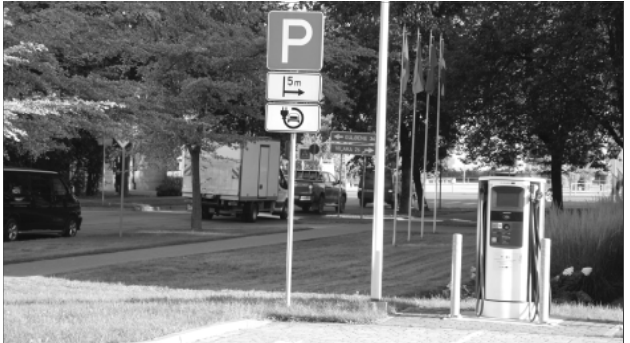
Balvos, Bērzpils ielā 62. Uzlādes punkts ekspluatācijā nodots 2023.gada 30.novembrī; izbūve izmaksāja EUR 57 925. Veikto uzlāžu apjoms uz 30.06.2024 – 0.
